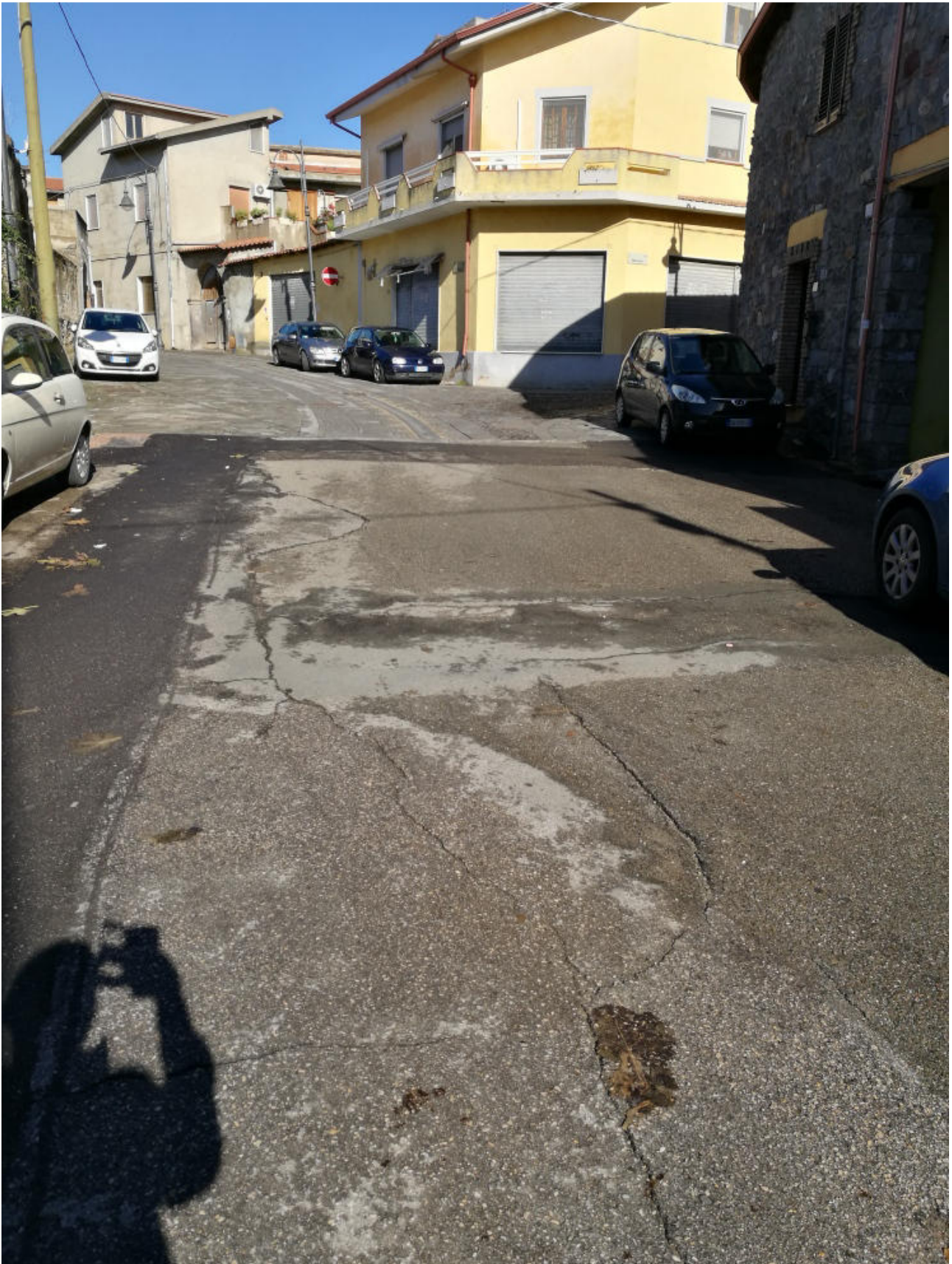
Foto n.14 – Serrenti: Via Salaris – incrocio via Mercato (attacco con pavimentazione in sanpietrini)
