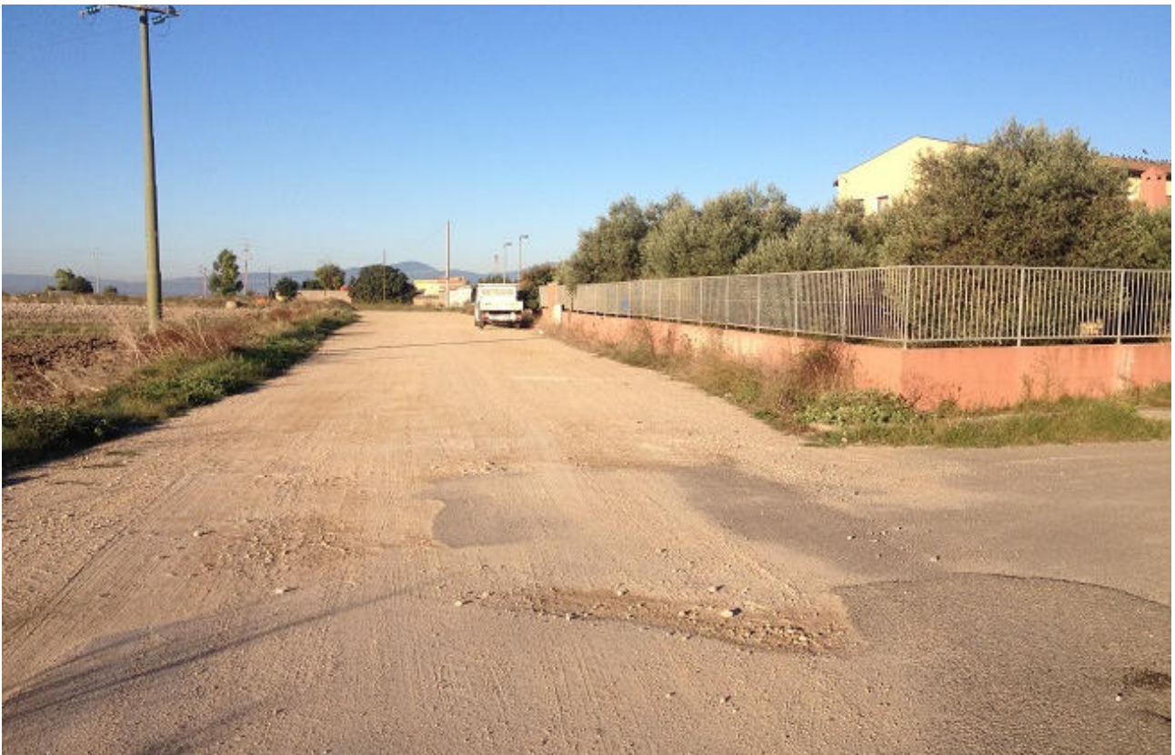
Foto n.17 – Serrenti: Strada Comunale Rio Cardaxiu-tratto largo (stato attuale viabilità)
