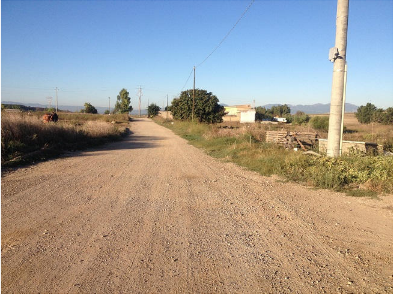
Foto n.18 – Serrenti: Strada Comunale Rio Cardaxiu tratto di larghezza 4,00m(stato attuale viabilità)
