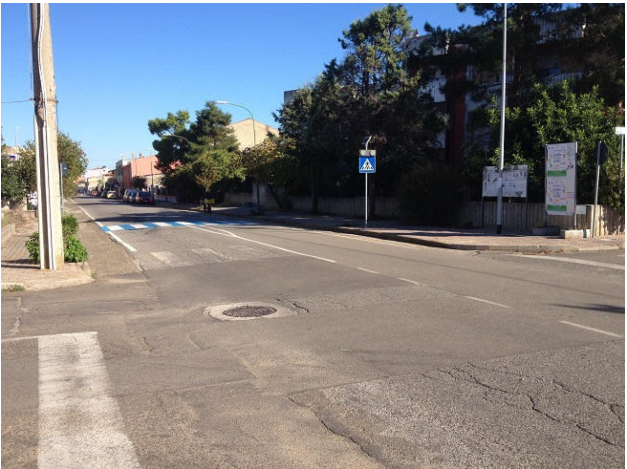
Foto n.1 – Pabillonis: incrocio via Cagliari – via Napoli (posizionamento passaggio pedonale rialzato)
