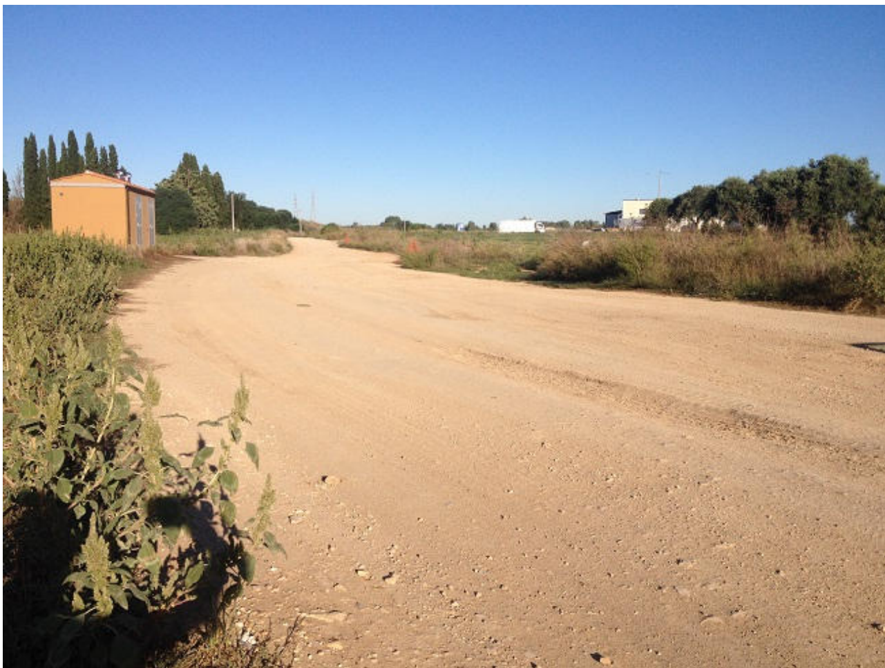
Foto n.20 – Samassi: Strada PIA - Villasanta (stato attuale viabilità)
